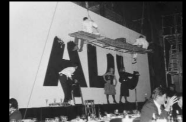
Fassadenmalerei im Studio Maur
